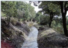
Acequia de careo: un sistema tradicional de recarga de acuíferos
